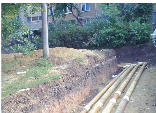
ППМ изоляция. Бесканальная прокладка.
